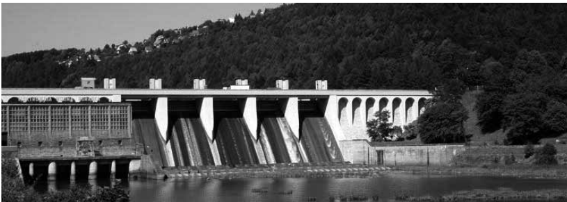
Rysunek 12. Elektrownia szczytowo-pompowa Porąbka-Żar
